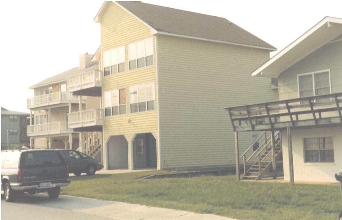
(d) One Broken Window
